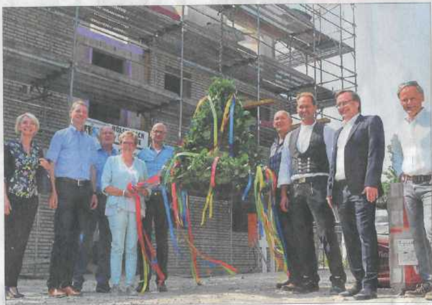
Gutgelaunt ist am Freitag Richtfest beim Mehrfamilienhaus des Bauvereins Delmenhorst in Ganderkesee gefeiert worden. Den Richtspruch hat Zimmerermeister Andreas Munderloh gehalten. FOTO: THOMAS DEEKEN
